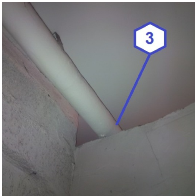
Local Eau 1er SSOL : Prélèvement calorifugeage conduites d'eau. Non Amianté.
