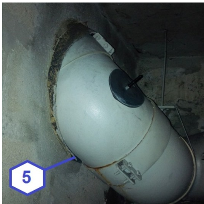
Local Technique 2eme SSOL : Prélèvement joint bitumineux. Non Amianté.
